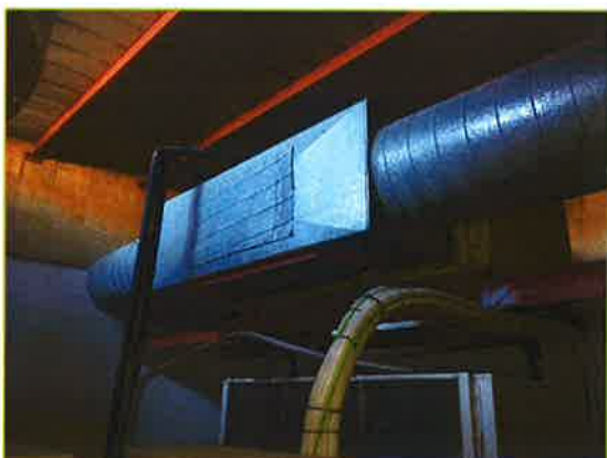
Imagen 4. Interior de cubierta sala de máquinas
