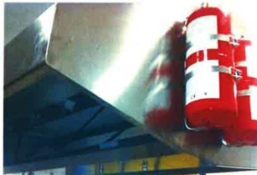
Para ello se valora sistema de extinción automático de inundación total para campana de cocinas industriales con activación mediante detección por incremento elevado de temperatura a través de cable térmico o accionamiento manual mediante pulsador.
