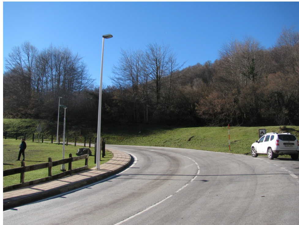
FOTO 5: En esta otra fotografía podemos apreciar, la existencia de unas aceras en el margen izquierdo de la carretera CA-185. Se prevé conservar dichas aceras, para que sirvan de mediana entre la calzada actual y la calzada duplicada.
