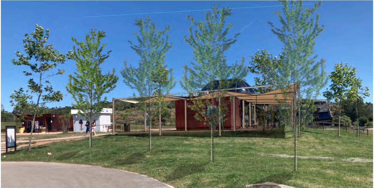
Los toldos se montarán sobre estructuras tubulares desmontables de acero galvanizado, a base de piezas atornilladas. Irán pintados en tonos ocres, similares al acero corten, integrados en el entorno y tensados con cadenas a suelo, para facilitar la evacuación de aguas pluviales. Al pie de esas cadenas se abrirán “arquetas” de grava para evitar encharcamientos y que las pluviales drenen en el propio terreno.
