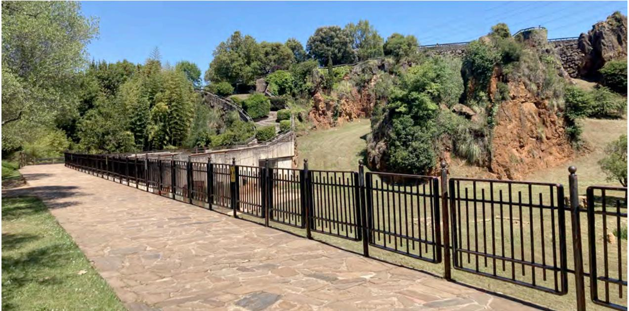
Sobre estas líneas, estado actual de la valla de forja existente. Al pie, propuesta de modificación, mediante la sustitución del enrejado por un vidrio 8+8, cortando las bolas de los pies derechos y colocando L de acero corten a modo de pasamanos, que evite su utilización como asiento. Se colocarán vinilos adhesivos con el logotipo de SEO Birdlife para evitar impactos de aves.
