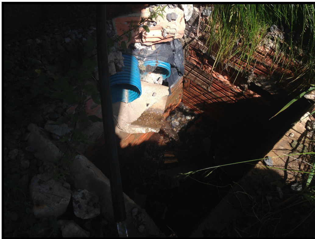
Imagen 3.- Arqueta actual de salida de aguas grises junto al edificio
