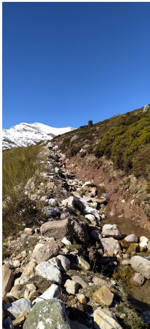
Ilustración 5. Áridos depositados en el canal.
