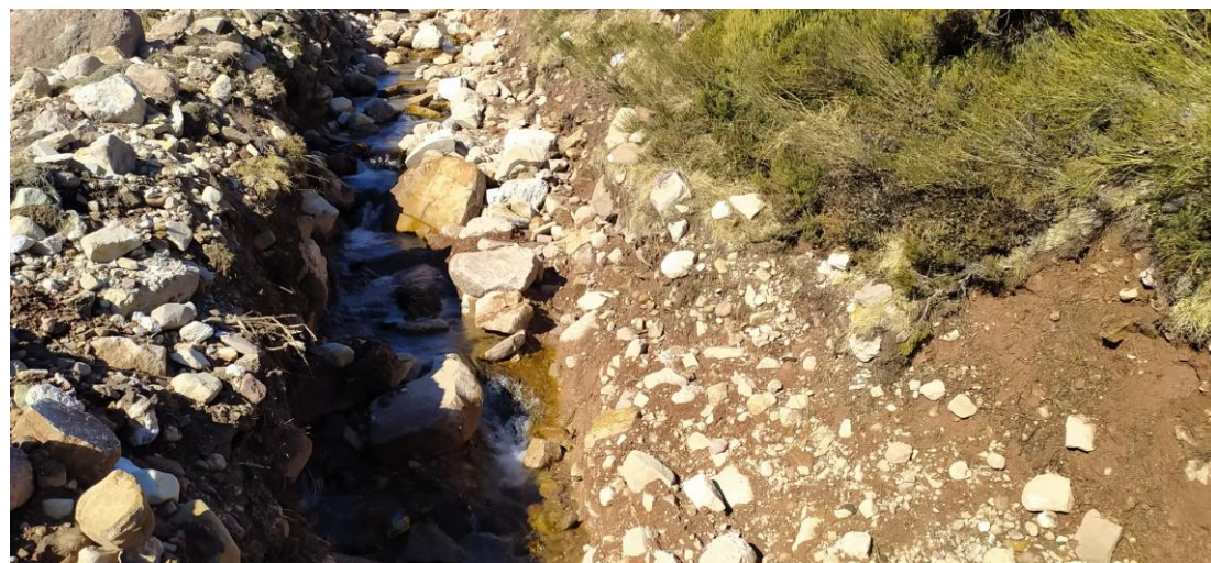
Ilustración 6. Áridos depositados en el fondo del canal de guarda.
