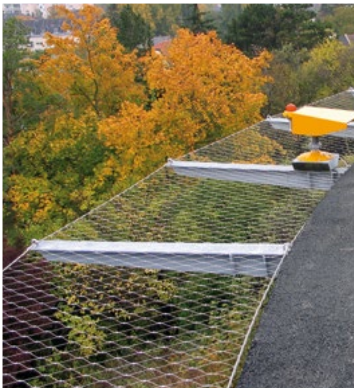
Stehende Masche_Vertical mesh diamond direction
