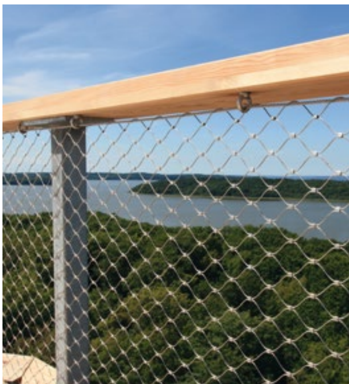
Liegende Masche_Horizontal mesh diamond direction
