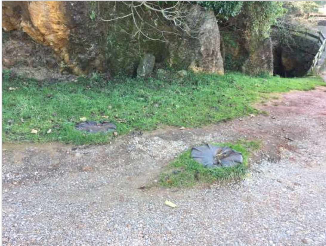
Fotografía 56. Fosa séptica actual. Punto final del colector de saneamiento existente en la zona de Gorilas. Al fondo, a la izquierda, sima en la que actualmente vierte la citada fosa séptica.
