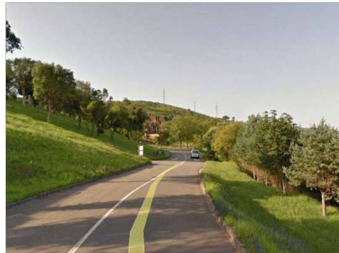
Fotografía 36. Nueva infraestructura de abastecimiento y fibra óptica por calzada derecha.
