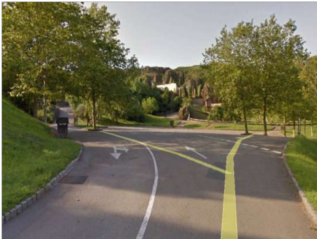
Fotografía 38. Nueva infraestructura de abastecimiento y fibra óptica por calzada derecha.
