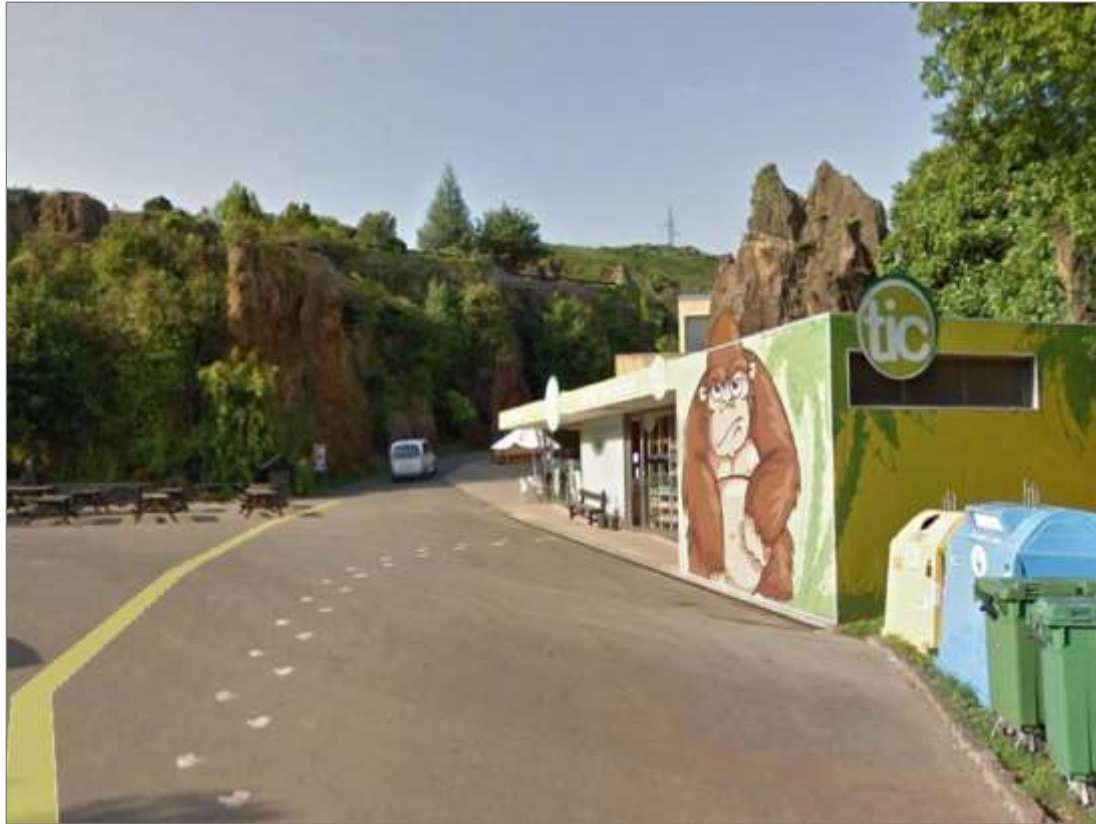
Fotografía 45. Nueva infraestructura de abastecimiento y fibra óptica hacia edificio Gorilas.
