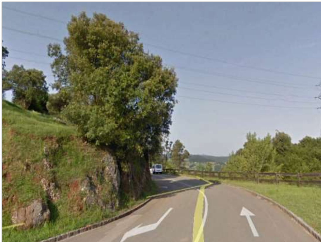
Fotografía 30. Nueva infraestructura de abastecimiento y fibra óptica por calzada derecha.
