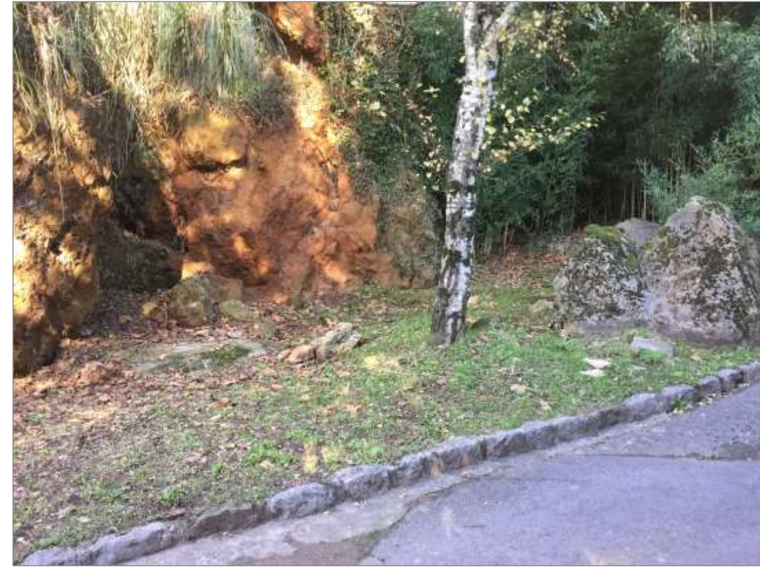
Fotografía 43. Nueva infraestructura de abastecimiento y fibra óptica hacia Tigres.
