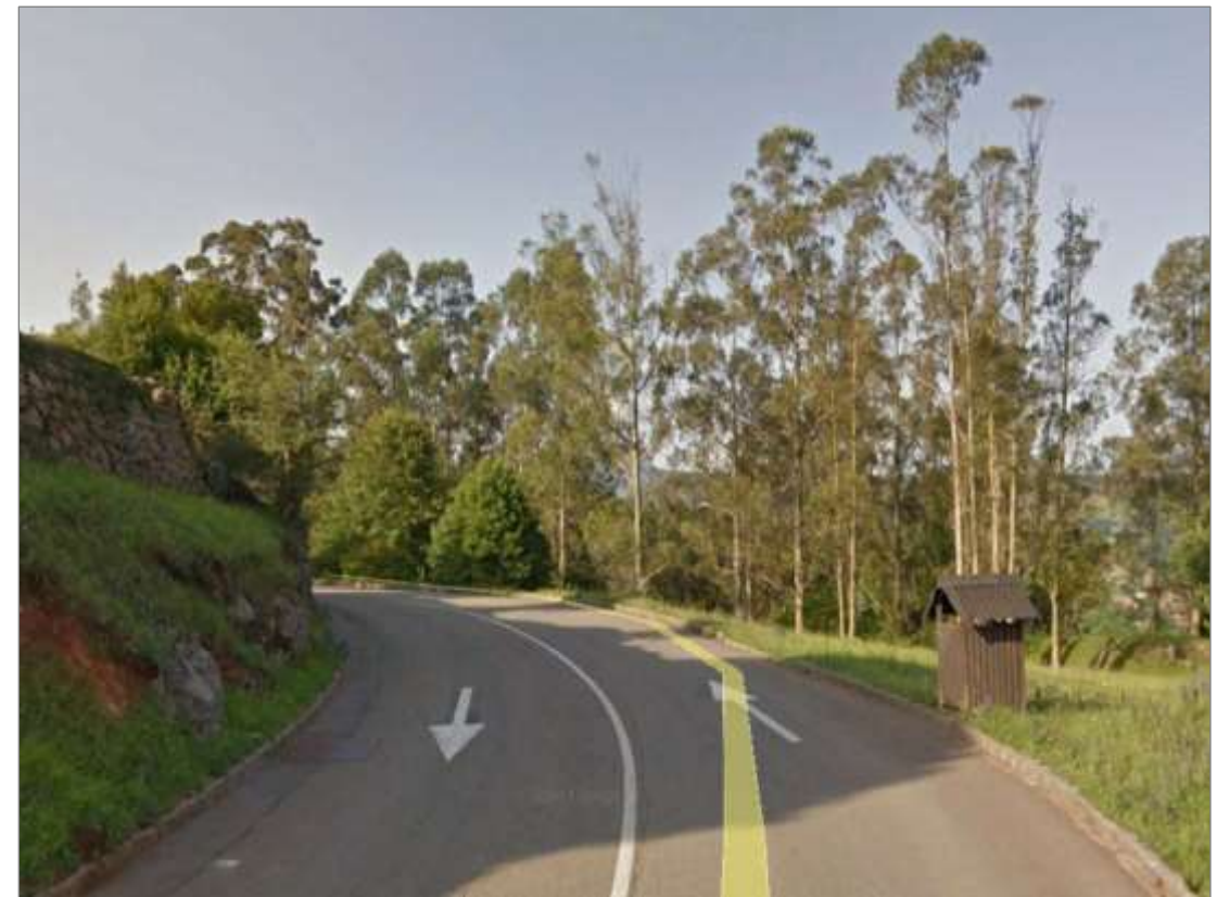
Fotografía 32. Nueva infraestructura de abastecimiento y fibra óptica por calzada derecha.
