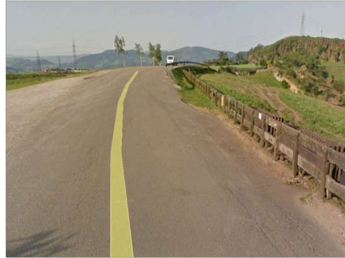
Fotografía 3. Cruce de infraestructura de fibra óptica y canalización eléctrica con vial.
