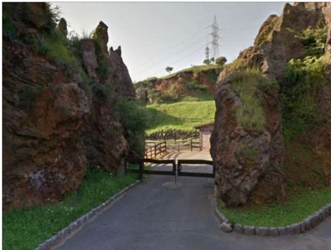
Fotografía 18. Punto de inicio de nueva infraestructura de fibra óptica y electricidad BT.
