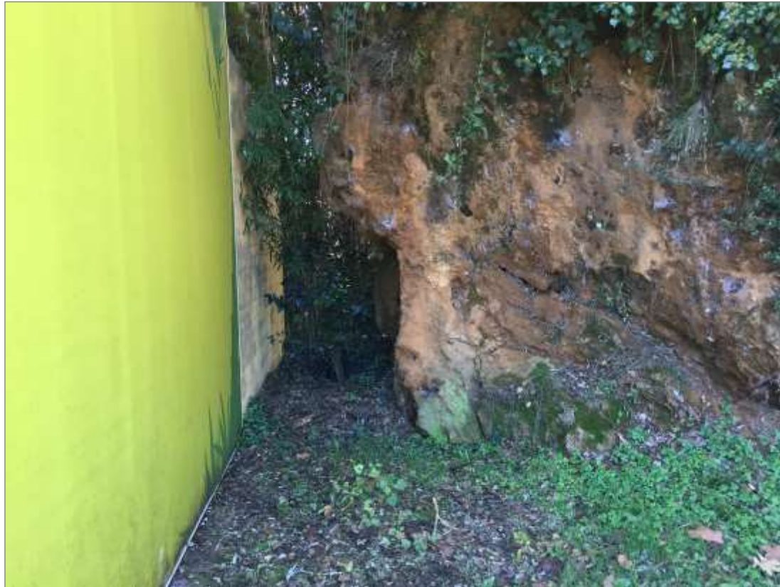
Fotografía 54. Continuidad del colector de saneamiento actual por detrás de la Cafetería Gorilas.
