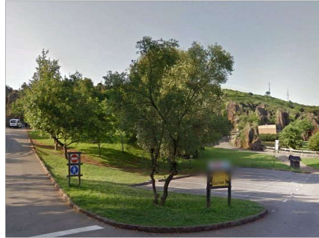
Fotografía 60. Tramo inicial de "Colector Gorilas-La Mina" por zona verde (vista opuesta a sentido evacuación).
