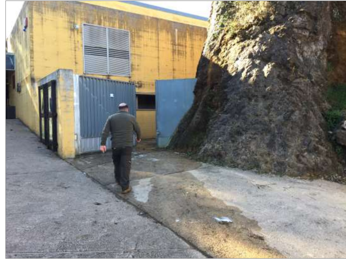
Fotografía 50. Edificio Gorilas: Punto de inicio del colector de saneamiento actual.
