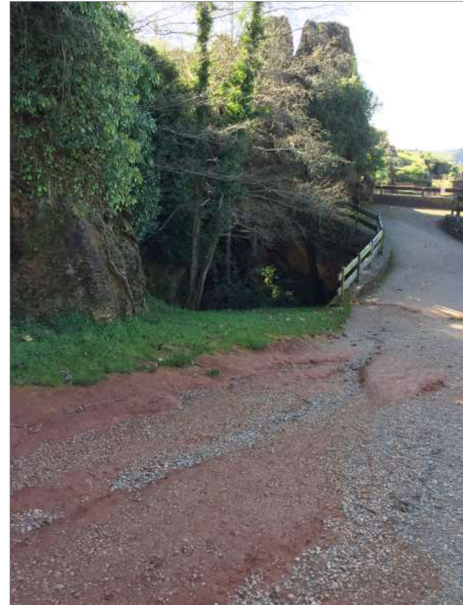
Fotografía 57. Punto final de evacuación de la red de saneamiento existente en la zona de Gorilas.
