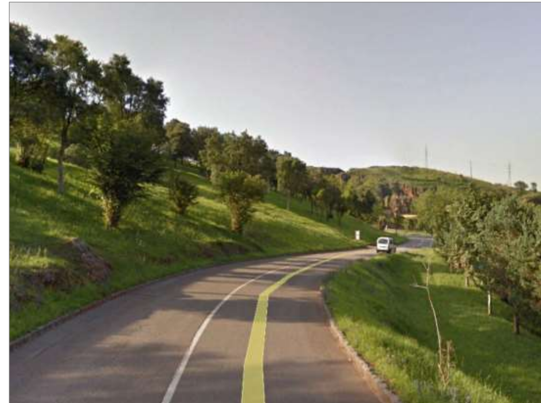
Fotografía 35. Nueva infraestructura de abastecimiento y fibra óptica por calzada derecha.
