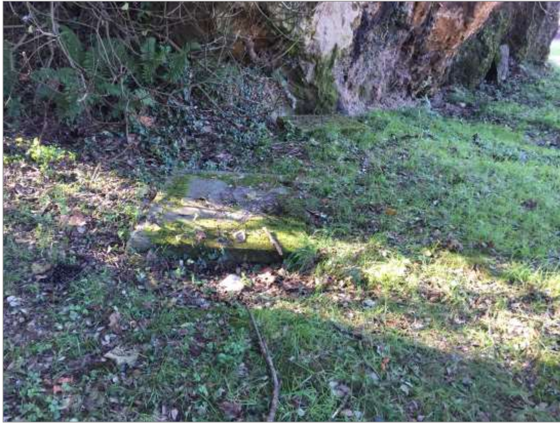
Fotografía 58. Arqueta de saneamiento existente. Punto de inicio del futuro "Colector Gorilas-La Mina".
