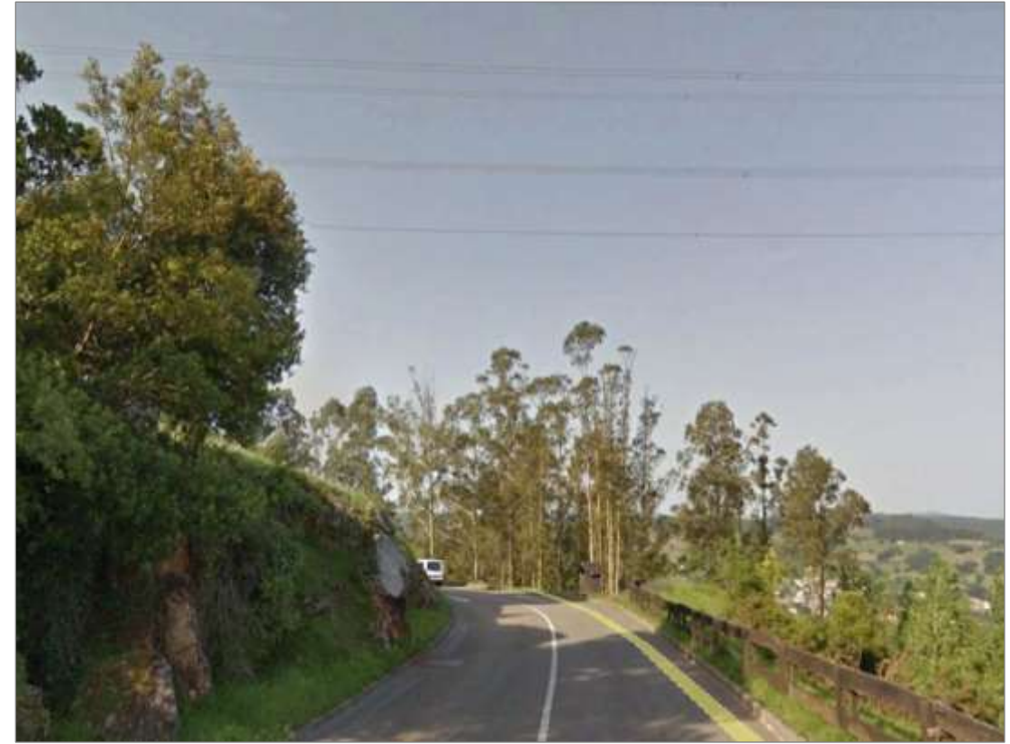
Fotografía 31. Nueva infraestructura de abastecimiento y fibra óptica por calzada derecha.
