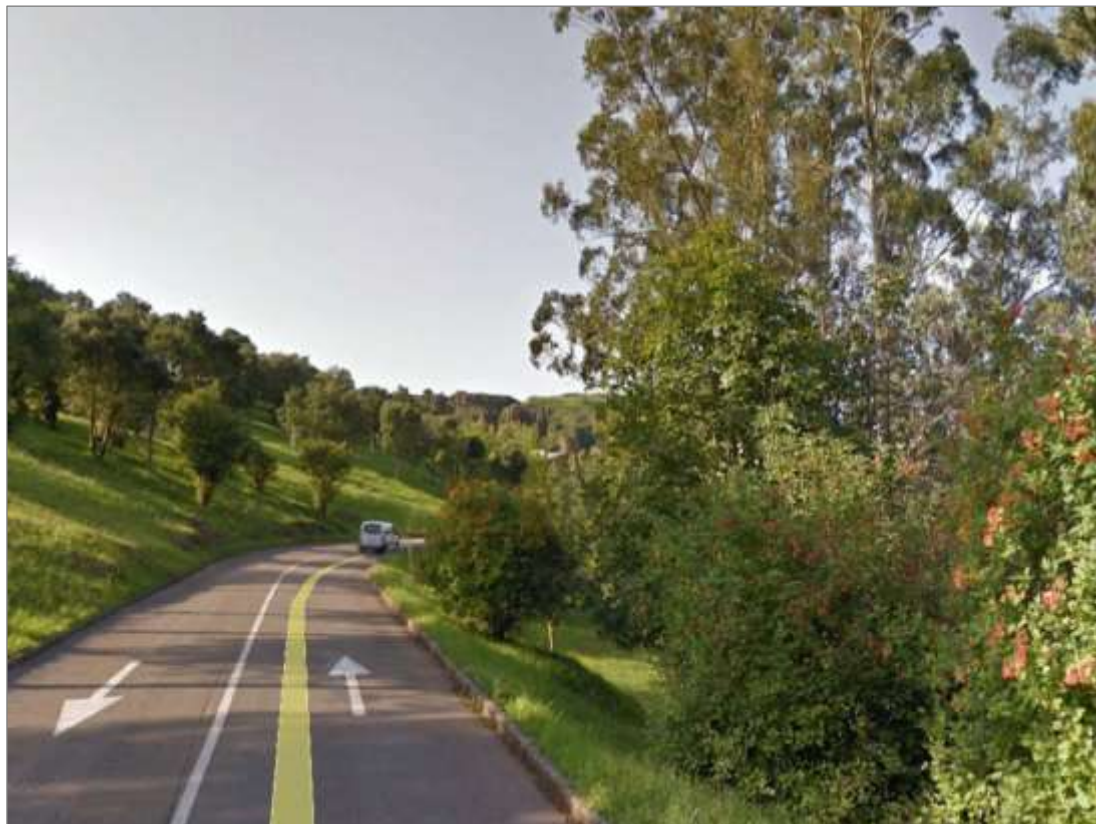
Fotografía 34. Nueva infraestructura de abastecimiento y fibra óptica por calzada derecha.
