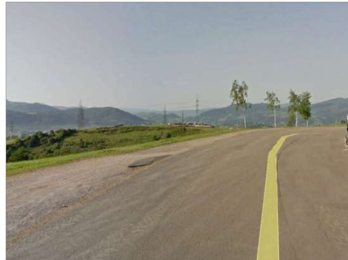
Fotografía 4. Infraestructura de fibra óptica y canalización eléctrica proyectada a 2 m desde margen de carretera.
