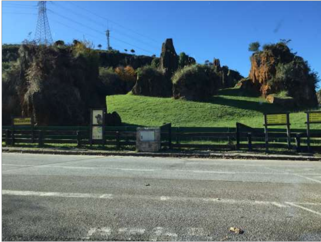
Fotografía 9. AV-08 existente desde donde se conecta la nueva línea de BT hacia Rinoceronte Blanco.
