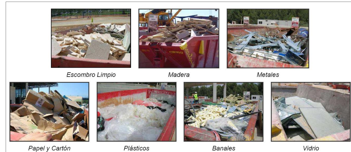
Figura 3. Ejemplos de contenedores para la correcta separación de los residuos de construcción y demolición
