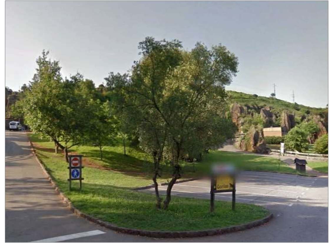
Fotografía 39. Infraestructura de abastecimiento y fibra óptica. Zona común con "Colector Gorilas-La Mina".
