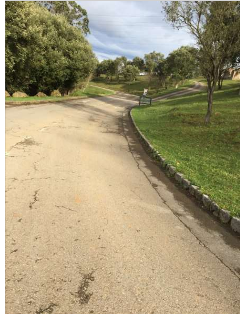
Fotografía 63. Trazado de "Colector Gorilas-La Mina", abastecimiento y fibra óptica por zona izquierda de la calzada (vista en sentido de evacuación).
