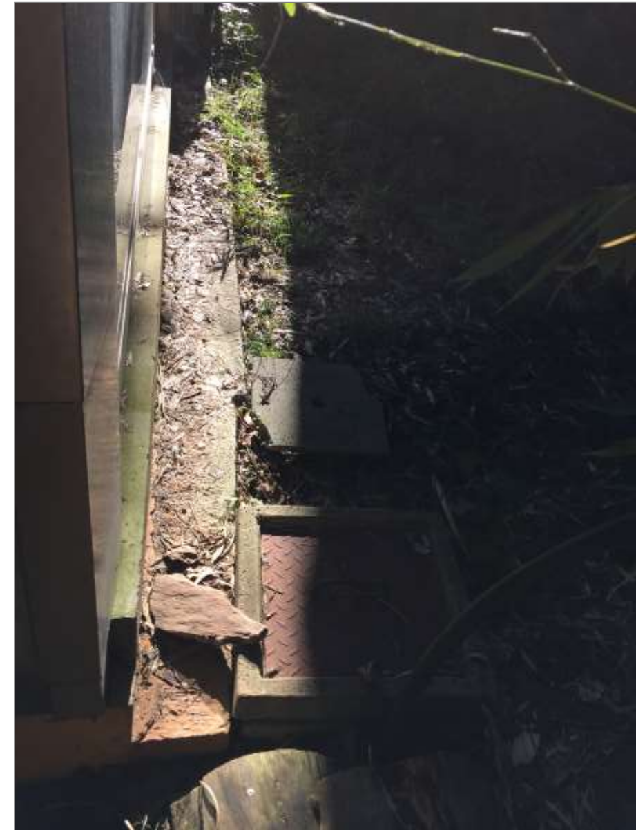
Fotografía 53. Paso del colector de saneamiento anterior por detrás de la Cafetería Gorilas.
