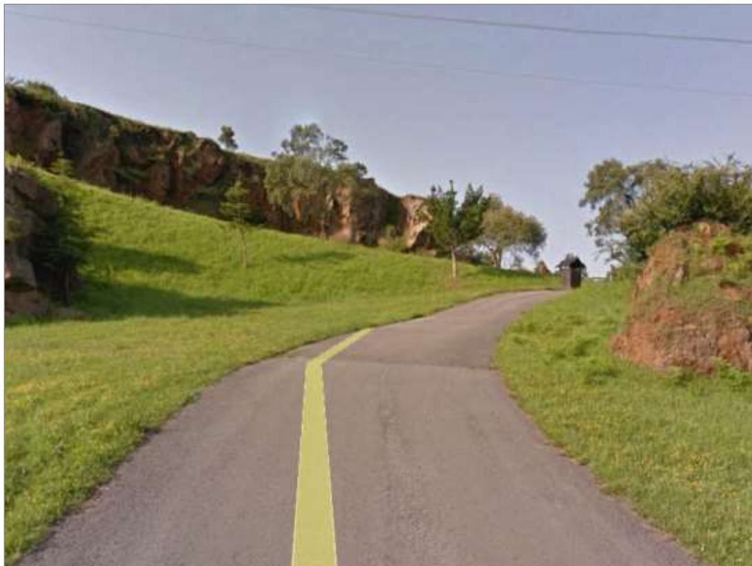
Fotografía 22. Trazado de nueva infraestructura de fibra óptica y electricidad BT por zona verde izq.
