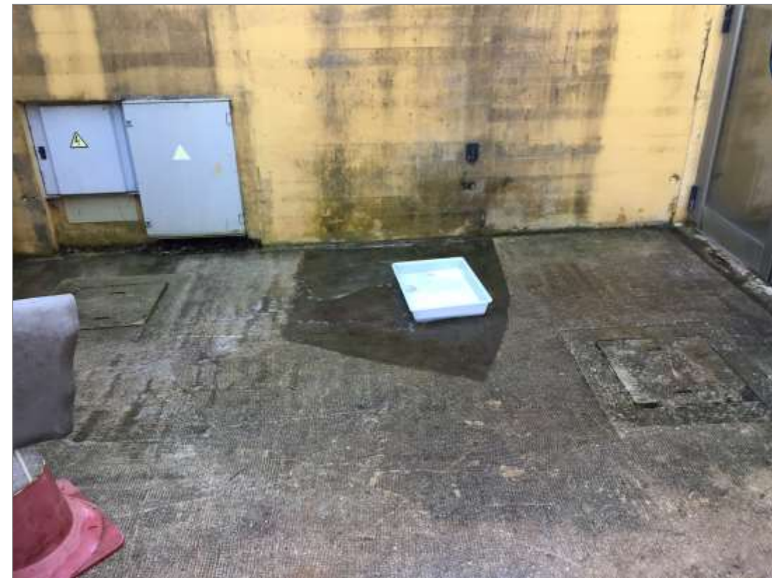
Fotografía 51. Edificio Gorilas: Arqueta inicial del colector de saneamiento actual.
