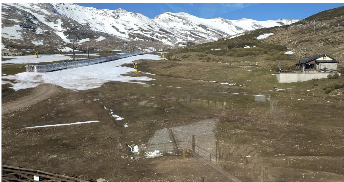
Estado actual del ámbito de actuación. Se aprecian los rellenos sobre los que se extienden las pistas de esquí y la cinta de transporte de esquiadores.
