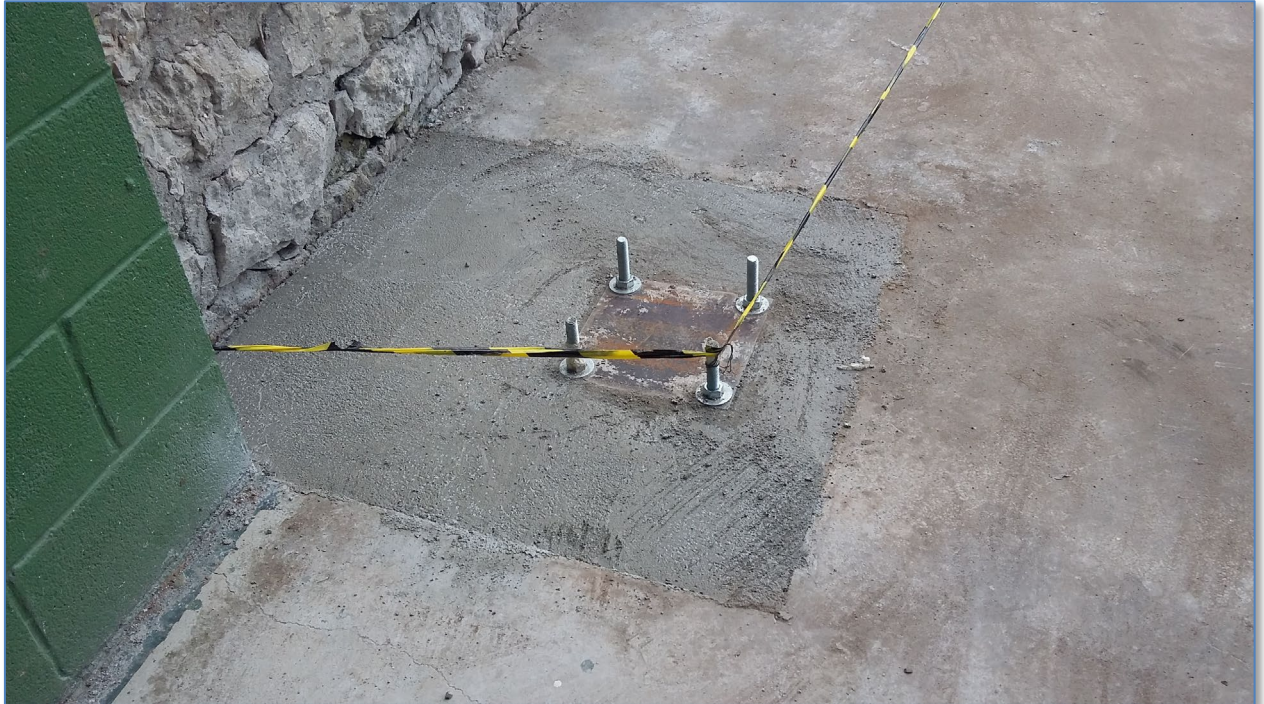
Imagen 4.- Imagen de una zapata con su placa de anclaje para la estructura soporte.
