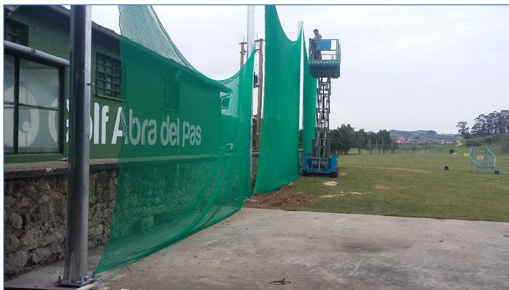
Imagen Nº5.- Colocación de la estructura soporte y la red de nylon de alta resistencia.
