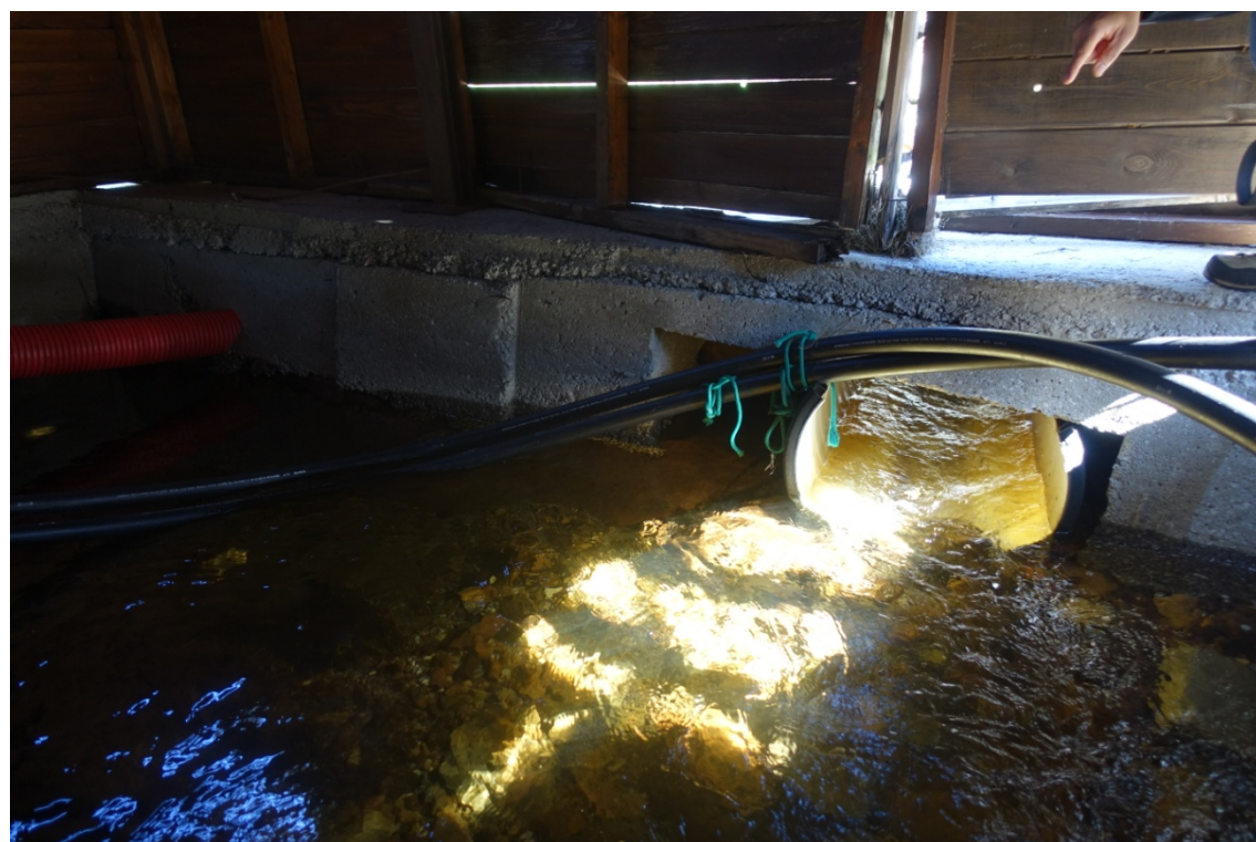
FOTO 3: Otra vista interior de la actual captación. No se pretende actuar en esta captación, únicamente conectar las dos nuevas tuberías de salida, que irán a una profundidad de 1,20 metros.
