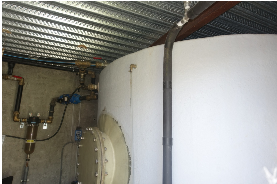
FOTO 11: Punto de conexión final en depósito de poliéster de 15.000 litros.
