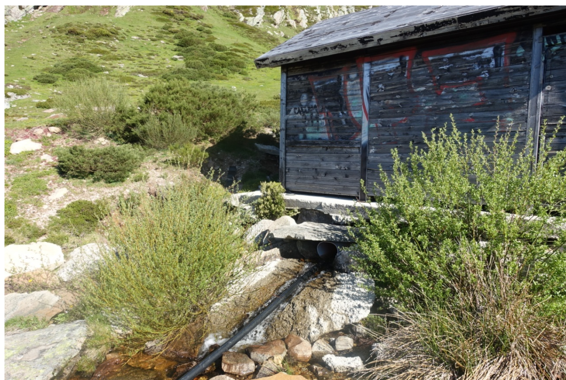
FOTO 1: Caseta de madera en donde se encuentra ubicada actualmente la captación de CANTUR, S.A., con una concesión de 1 litro/seg. Se puede observar que actualmente las tuberías son aéreas, con los consiguientes problemas de congelación que esto supone en época invernal. En esta actuación, también se contempla la eliminación de todas las conducciones que se encuentran tendidas en superficie y la limpieza de elementos antrópicos.
