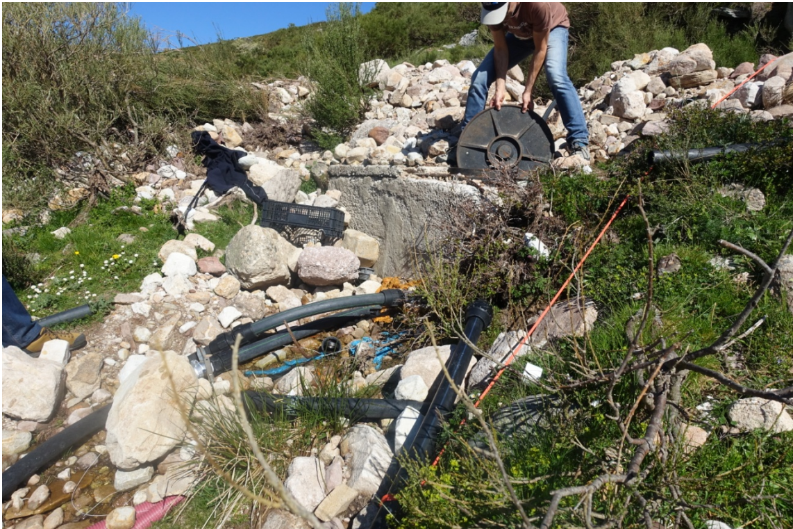
FOTO 7: Estado actual del depósito. En este punto construiremos el nuevo depósito de cabecera de 18 m3, en sustitución del actual. Por la parte superior discurre un canal con mucho arrastre de sólidos como se puede apreciar, por lo que esta zona irá protegida con piedra de escollera.
