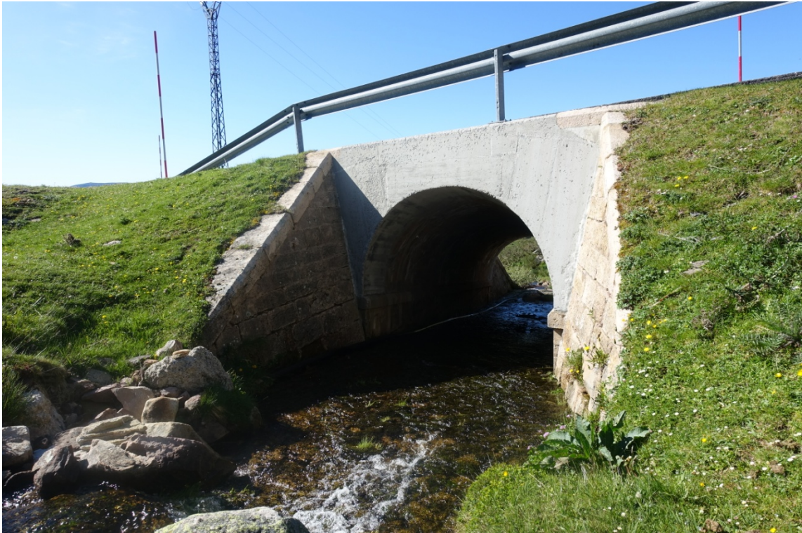
FOTO 6: Vista de la zona aguas arriba de la obra de fábrica por la que cruzaremos las dos tuberías. Estas discurrirán por el lateral derecho a una profundidad de 1,00 m desde la generatriz superior de los tubos hasta el lecho fluvial, que una vez colocadas deberá restaurarse a su estado original.
