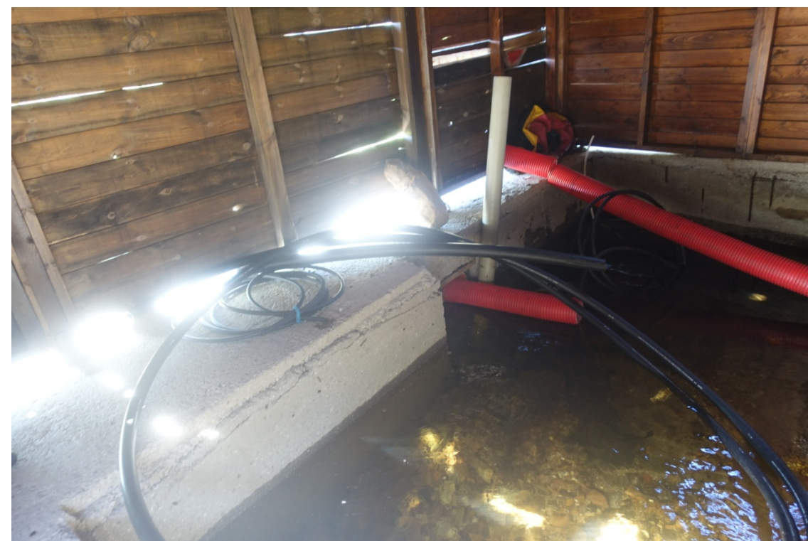
FOTO 2: En esta otra fotografía podemos observar como es su interior, en el que se puede apreciar un recinto de hormigón con diversas salidas y un aliviadero para la evacuación del excedente.
