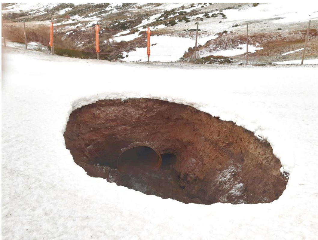
Foto 5. Detalle del hundimiento en la pista Río Híjar II.
