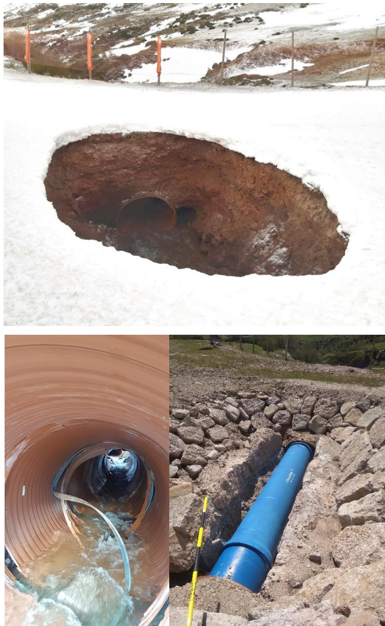
Fotografía 2. Daños registrados en la OP.RH.5 y reparación provisional a mitad de pista.
