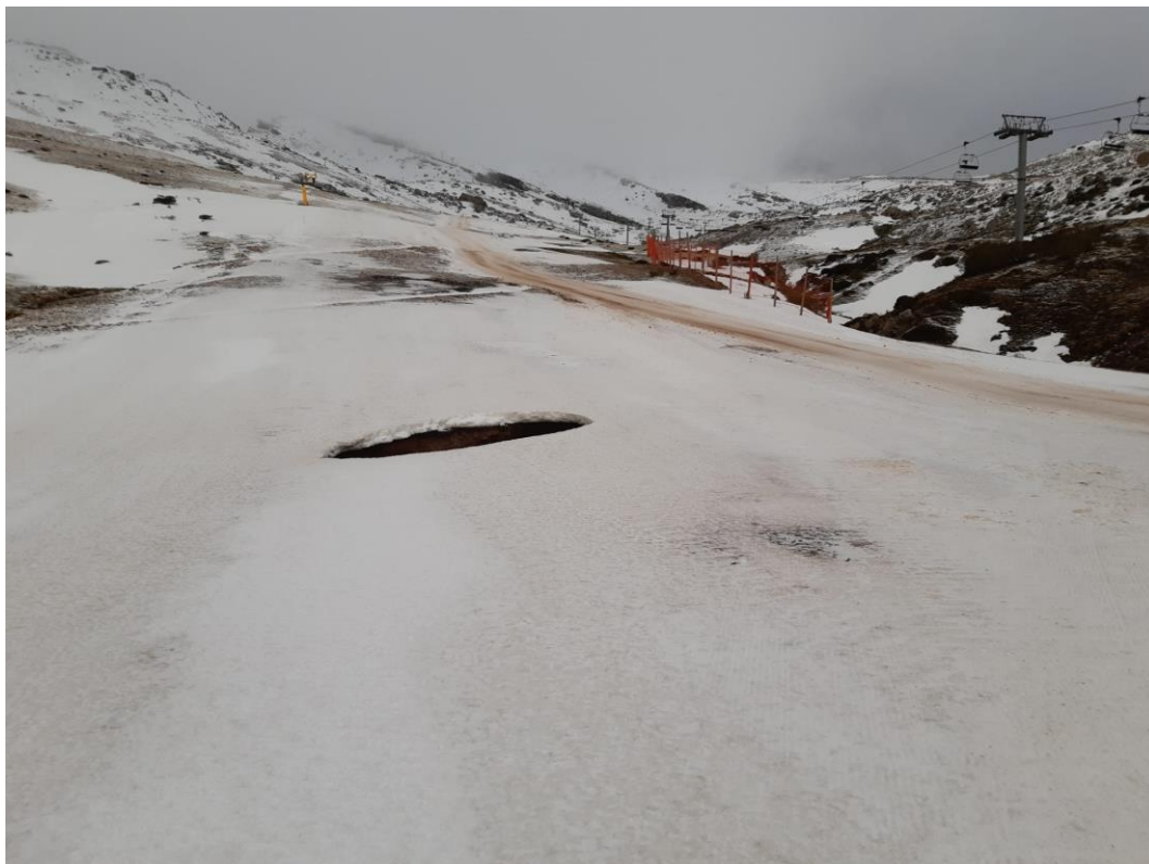
Foto 4. Hundimiento detectado en la pista Río Híjar II tras el episodio del 20 de diciembre de 2019.
