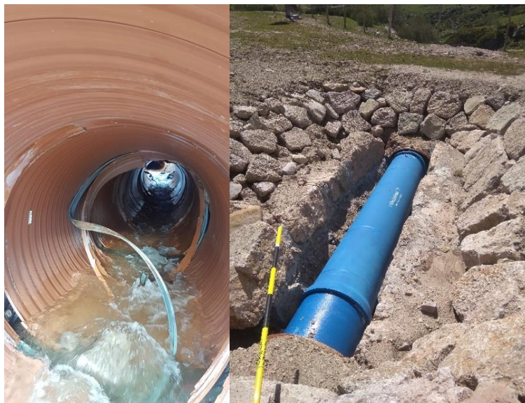
Fotografía 2. Daños registrados en la OP.RH.5 y reparación provisional a mitad de pista.
