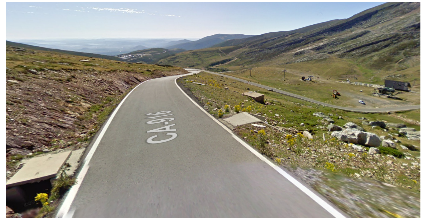
FOTO 4: En esta fotografía se puede apreciar por donde se realizará el cruce de la carretera autonómica CA-916 (por obra de fábrica existente). En segundo término se puede apreciar la ubicación del depósito de 4 metros cúbicos, en el que colocaremos el flotador.
