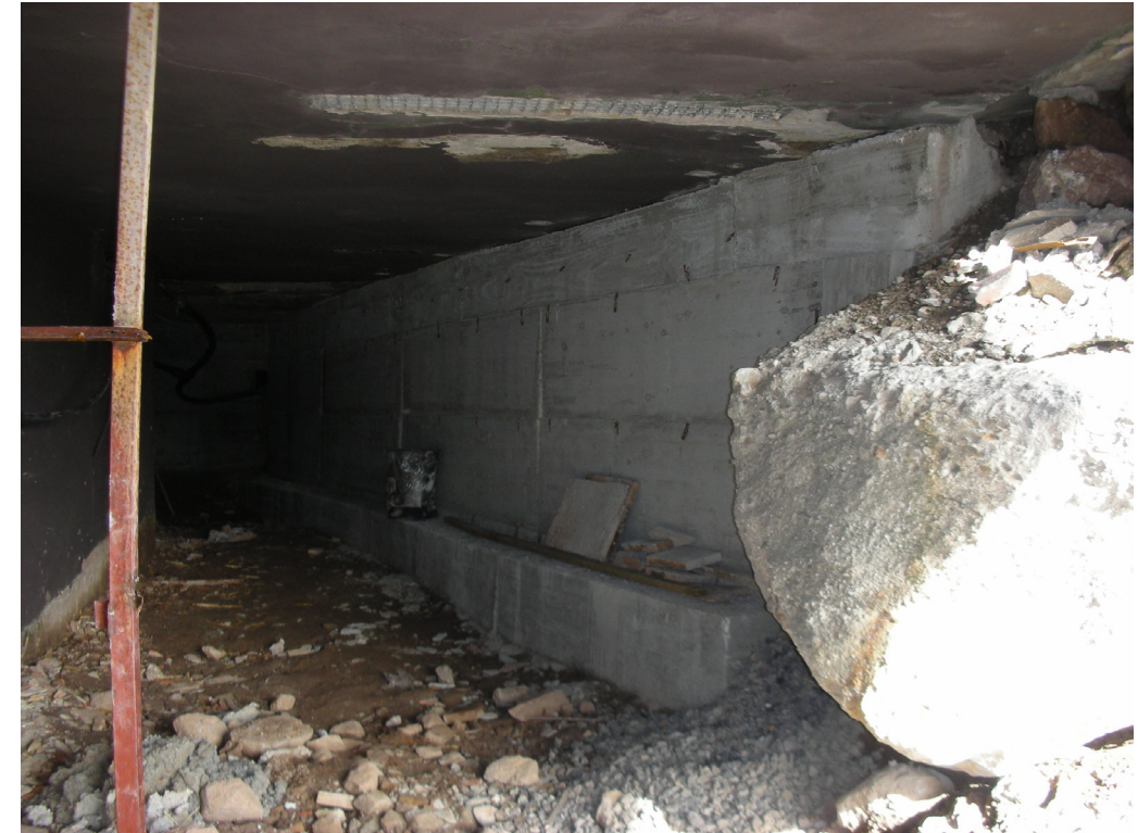
FOTO 6: En esta fotografía apreciamos la zona destinada a los equipos. Será necesario acondicionar el suelo con la ejecución de una solera de hormigón armado y colocar una puerta en el hueco para restringir el paso.
