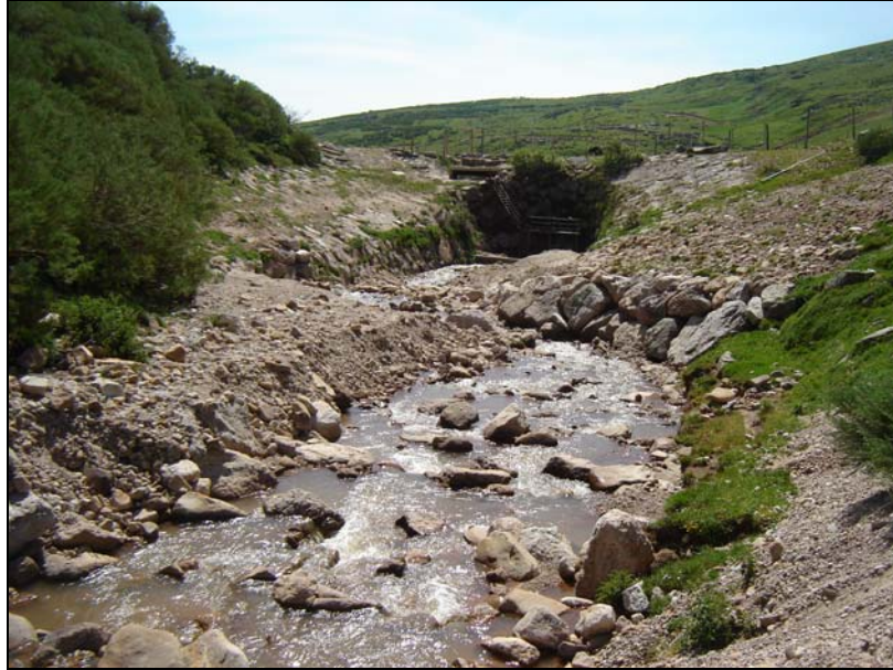
Cauce del Híjar. Vista dirección aguas abajo desde el pK 0+069.
